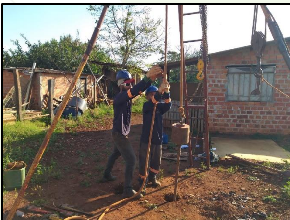
Execução de sondagem SPT
